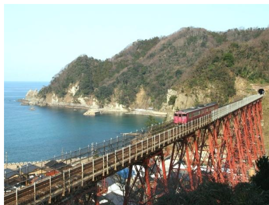
初代余部鉄橋。赤い柱が林立し、列車が走る橋桁を支えています。架け替え工事が本格化する前の2008年3月撮影。
