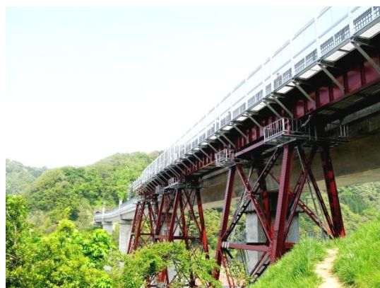
橋の北西側から見た「空の駅」。新しい白い橋に沿って、ぷつぷつと切れた初代の鉄橋が残っています。
