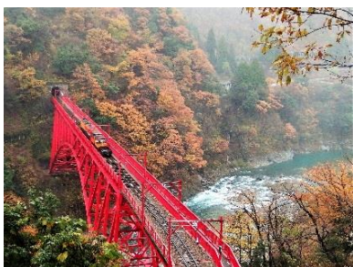
宇奈月駅近くの展望台から見る新山彦橋。晩秋とはいえ雪がちらつく天候でした。ちょうど橋の上を短い編成の貨物列車が走っていきます。
