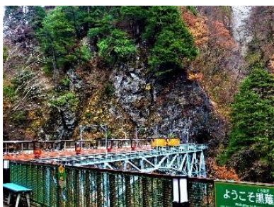
黒薙駅を出ると列車は急カーブを曲がり、後曳橋を渡ります。高さ60mの橋の上から川底を見下ろすと、目がくらみそうです。
