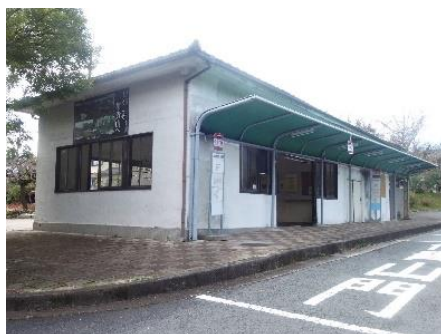
信貴山のバス停の待合室は、かつての東信貴ケーブルの終点、信貴山駅の駅舎を転用したものです。ここから朝護孫子寺までは徒歩10分程度です。
