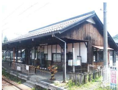
水口（みなくち）駅の木造駅舎。この駅は 1900 年（明治 33 年）に開業しました。近江鉄道にはこのような味わい深い駅舎がいくつかあります。
